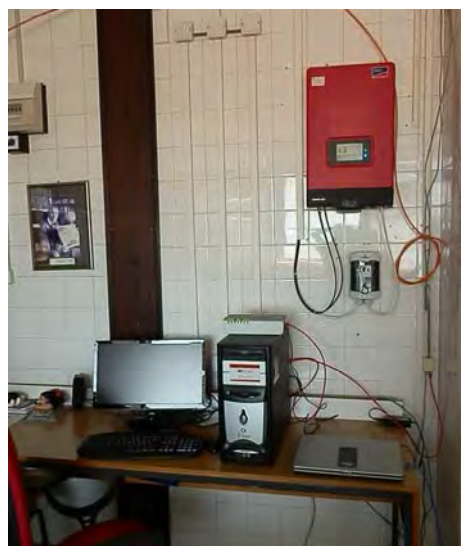
Sl. 3.14. Unutrašnjost Laboratorije za solarnu energetiku na PMF-u u Nišu sa postavljenim invertorom, WEBBOX -om i AC razvodnim ormanom
