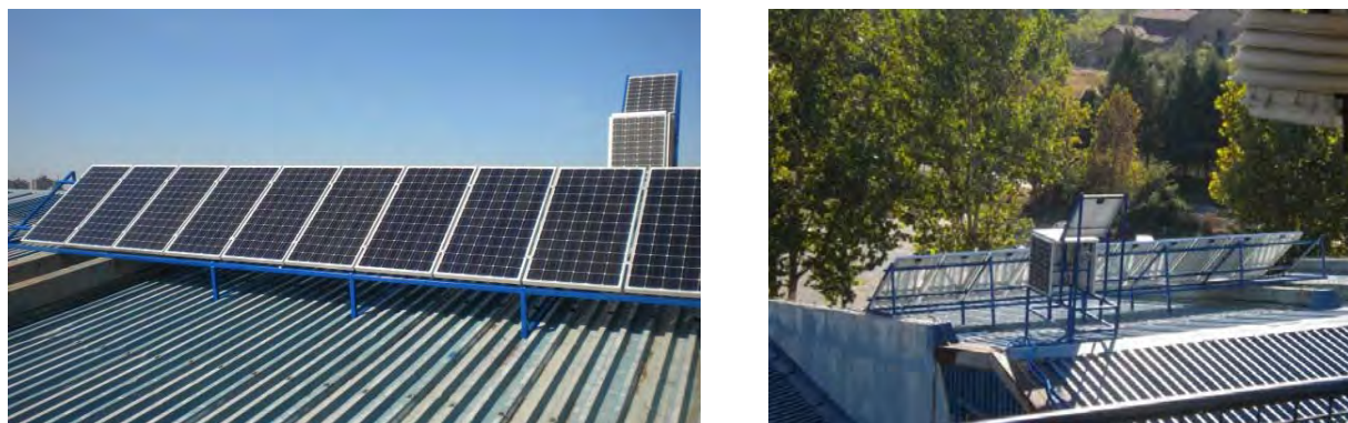
Sl. 3.12. Izgled instalirane solarne elektrane snage 2kW na krovu PMF-a u Nišu
