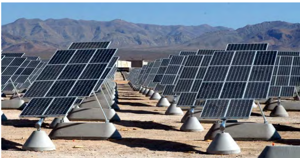
Sl. 1.26. Dvoosno rotaciona solarna elektrana
