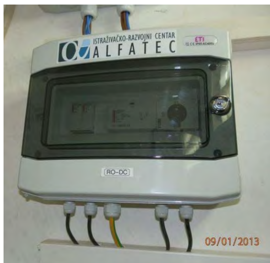
Sl. 3.13. Izgled DC razvodnog ormana
